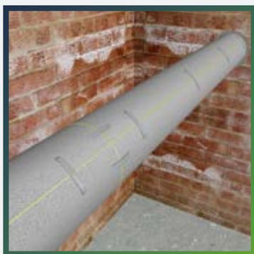
Повторите процедуру склейки разреза изоляции на следующем отрезке трубы, затем прижмите друг к другу торцы уже смонтированных соседних теплоизоляционных трубок, при необходимости зафиксируйте их монтажными клипсами.
