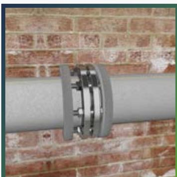
Измерьте периметр, применяя полоску Thermasheet требуемой толщины (равной толщине теплоизоляции, смонтированной на трубопроводе), затем вырежьте полоску требуемой ширины, равной расстоянию между кольцами, которое можно измерить линейкой.
