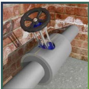
Произведите монтаж изоляции фланцев вентиля, используя указания п. 8.7.
