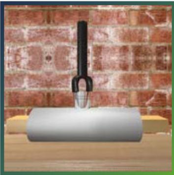
В той из них, которая предназначена для изоляции основного участка трубопровода, следует сделать отверстие с использованием металлического пробойника. Диаметр отверстия должен быть на 1-2 мм больше диаметра отвода.
