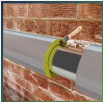
Нанесите тонкий ровный слой клея на торцы соединяемых трубок. Смонтируйте изоляцию на следующий участок трубопровода. Замок рекомендуется закрывать в направлении ранее смонтированного участка теплоизоляции.
