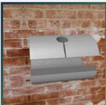
Отрежьте кусок теплоизоляционной трубки нужной длины, достаточной для изоляции крана с нахлестом на смонтированную ранее изоляцию. Разрежьте изоляцию вдоль, затем выполните продольный разрез посередине. С помощью пробойника сделайте круглое отверстие, равное диаметру ножки крана.
