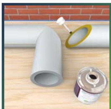
Нанесите ровный тонкий слой клея на полученный в результате предыдущей операции срез, а также на срез в  $45^\circ$  третьего отрезка изоляции. Дайте клею слегка просохнуть.
