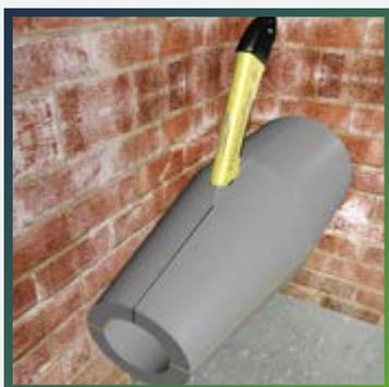
Аккуратно разрежьте изоляционную деталь вдоль по технологическому шву.
