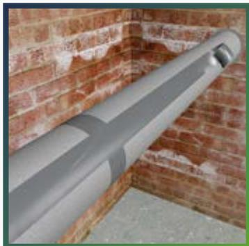
Через 24 часа, после полного высыхания клея, снимите клипсы. Для герметизации соединений проклейте швы армированным скотчем POLYKEN.
