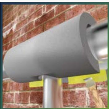
Смонтируйте полученную деталь на трубопровод, аккуратно склеивая места разрезов. При необходимости зафиксируйте швы монтажными клипсами THERMACLIPS.
