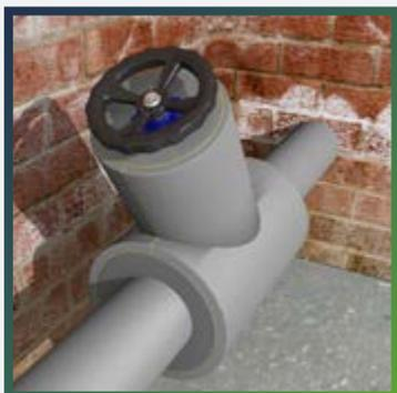
Срежьте кромки кривой линии под углом  $45^\circ$  по направлению к той стороне, которая будет внутренней при монтаже. Смонтируйте изоляционную деталь, тщательно склеивая концы деталей. Аккуратно приклейте деталь и к изоляционному кольцу, и к изоляции фланцев вентиля.
