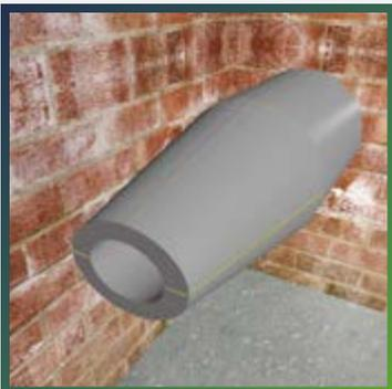
Нанесите на поверхности разрезов ровный тонкий слой клея THERMAFLEX. Прижмите их друг к другу.
