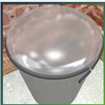
Применяя узкую полоску теплоизоляции соответствующей толщины, измерьте периметр резервуара (не растягивая при этом полоску!). Измерьте высоту резервуара.
