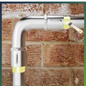
Монтаж начинается с прямолинейных участков трубопровода, для монтажа которых следует использовать схему, описанную в п. 8.3. Чтобы избежать смещения изоляции, нанесите клеевой слой на участки трубопровода, прилегающие к местам увеличения его диаметра.
