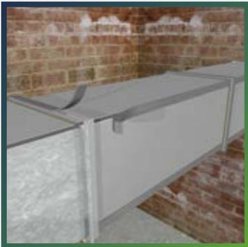
Когда клей подсохнет, приклейте теплоизоляционные планки встык к фланцам. Зафиксируйте швы самоклеящейся лентой Thermatape.
