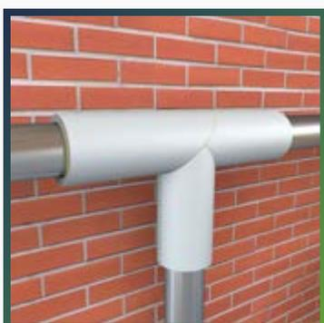
Осторожно соедините края разреза и тщательно прижмите склеиваемые поверхности.
