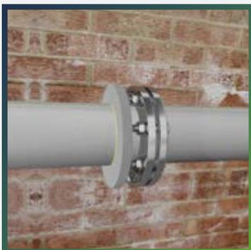
Приклейте внутренний периметр кольца к изоляции трубопровода с боков фланца, а также разрезанные концы, используя клей THERMAFLEX.
