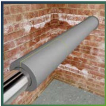
Измерьте общий диаметр трубопровода совместно с первым слоем теплоизоляции, используя при этом узкую полоску теплоизоляции той же толщины, которая будет использоваться при монтаже второго (наружного) слоя теплоизоляции. Отрежьте лист требуемого размера. Если позволяют размеры, то монтаж второго слоя выполните с использованием трубной теплоизоляции, внутренний диаметр которой должен равняться общему (суммарному) диаметру трубопровода и первого слоя теплоизоляции.
