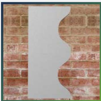
Аккуратно разрежьте теплоизоляцию по полученной кривой линии.
