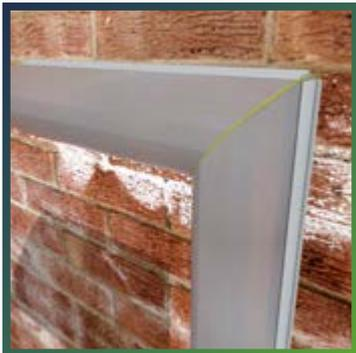
В случае монтажа теплоизоляции на изгибах трубопровода в 90°, разрежьте изоляционную трубку под углом 45°, используя стусло. Разверните один из полученных отрезков на 180°. Смонтируйте полученные детали, как показано на рисунке, предварительно нанеся на торцы слой клея. Зафиксируйте. Для герметизации соединений проклейте швы самоклеящейся лентой THERMATAPE.
