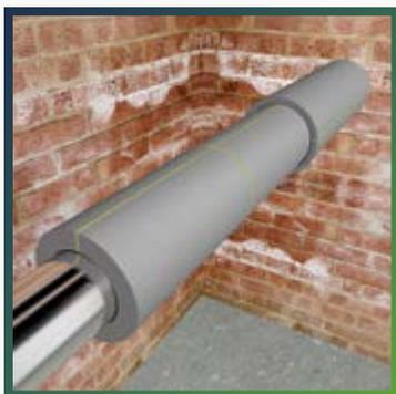
При монтаже второго слоя обеспечьте несовпадение продольных и поперечных швов слоев теплоизоляции. При необходимости аналогичную процедуру повторите для третьего слоя.
