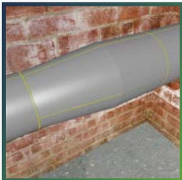
Смонтируйте полученную изоляционную деталь на трубопровод, склеив предварительно поверхности разреза и места стыков с соседними участками теплоизоляции. При необходимости зафиксируйте стыки монтажными клипсами THERMACLIPS. После полной полимеризации клея проклейте швы армированным скотчем POLYKEN для герметизации соединений.
