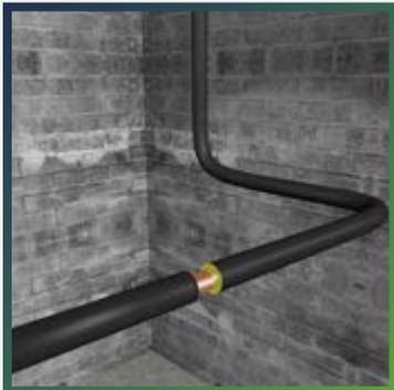
Аналогичным образом смонтируйте следующий участок изоляции на трубопровод. Сдвиньте его вплотную к предыдущему участку, торцы теплоизоляционных трубок склейте друг с другом. Зафиксируйте их.
