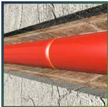
Смонтируйте следующую трубку на трубопровод. Нанесите клей на торец. Через 2-12 минут, в зависимости от температуры окружающей среды, когда клей подсохнет (перестанет прилипать к пальцам), аккуратно соедините торцы теплоизоляционных трубок. Зафиксируйте их.
