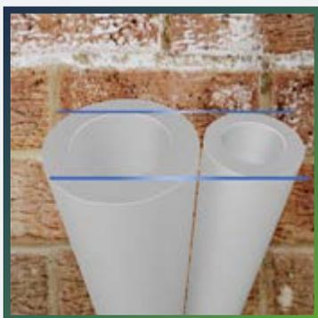
Подберите другой участок трубной теплоизоляции с внутренним диаметром равным внешнему диаметру трубок, используемых ранее для изоляции прямых участков трубопровода. Отрежьте от него фрагмент трубки нужной длины, достаточный для изоляции отвода с нахлестом на ранее изолированные прямые участки трубопровода.
