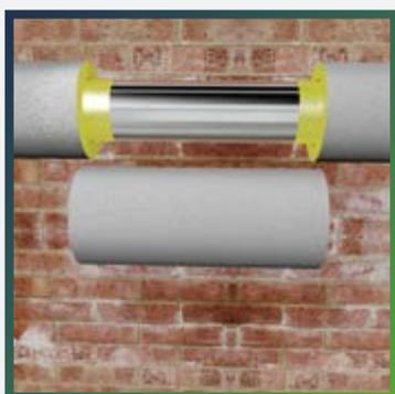
В процессе монтажа последнего участка теплоизоляции на трубопроводе образуется неизолированный участок, для которого необходимо вырезать отрезок трубной изоляции чуть большей длины (на 3-5 мм), чем длина самого участка. Тем самым исключается появление зазоров, которые могут привести к тепловым потерям на данном участке.
