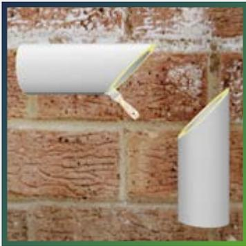
Нанесите на торцы соединяемых отрезков теплоизоляции тонкий ровный слой клея THERMAFLEX. Дайте ему немного просохнуть. Через 2-12 минут, в зависимости от температуры окружающей среды, когда клей подсохнет (он должен перестать прилипать к пальцам), осторожно соедините и прижмите отрезки изоляции.
