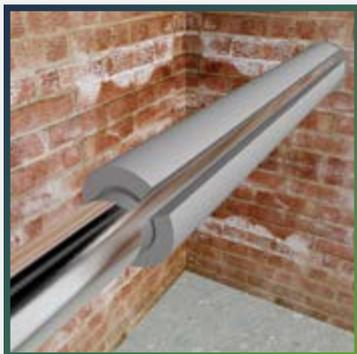
Оберните участок трубопровода изоляцией таким образом, чтобы края разреза не соприкасались.
