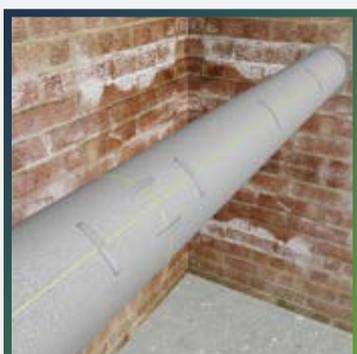
Склейте соседние участки теплоизоляции и при необходимости зафиксируйте швы монтажными клипсами THERMACLIPS.
