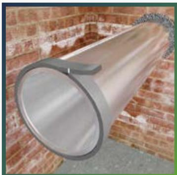
Оберните вокруг трубопровода узкую полоску теплоизоляции соответствующей толщины для измерения длины окружности изолируемого трубопровода.
