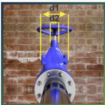
Измерьте диаметр фланца на фронтальной части вентиля, определите размеры и форму крышки штока вентиля. Нанесите полученные размеры на лист теплоизоляции и вырежьте диск требуемого размера.
