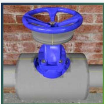
Наденьте изоляционный диск на шток вентиля. Склейте и прижмите стыки изоляционного диска.
