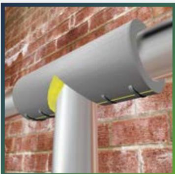
Смонтируйте полученную изоляционную деталь на трубопровод, аккуратно склейте места разрывов, зафиксируйте швы монтажными клипсами THERMACLIPS.
