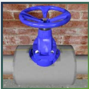
Когда клей подсохнет, оберните деталь вокруг вентиля и крепко прижмите склеиваемые торцы, а также места соединения детали с фланцевыми изоляционными кольцами.
