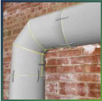
При необходимости зафиксируйте швы монтажными клипсами THERMACLIPS.
