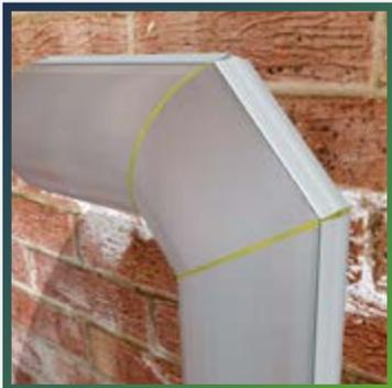
Если кривизна колена позволяет, то трубку Thermaflex Ultra M можно протолкнуть через колено: для облегчения процесса замок должен быть закрыт на длину около 30 см вдоль соседнего с коленом участка. Если продуть изоляцию не представляется возможным, то монтаж изоляции на колено следует производить методом сегментирования, описанным в п. 8.4.1.
