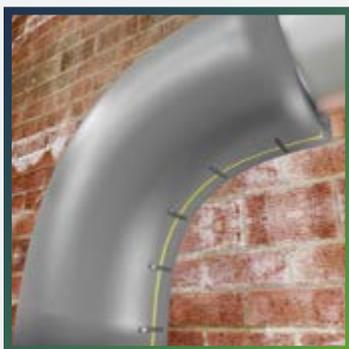
При необходимости зафиксируйте швы монтажными клипсами THERMACLIPS. После полного высыхания клея снимите клипсы и проклейте швы армированным скотчем POLYKEN для герметизации соединений. Если торцы получились не очень ровными, предварительно выровняйте их ножом.
