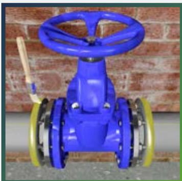
На торцы изоляционных колец, установленных на фланцах, нанесите тонкий ровный слой клея THERMAFLEX. Подождите, пока клей слегка подсохнет (перестанет прилипать к пальцам).
