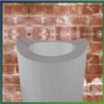
На другом отрезке, предназначенном для отвода Т-образного соединения, выполните U-образный вырез с торца изоляционной трубки, как показано на рисунке. Разрежьте ее вдоль для монтажа на трубопровод.
