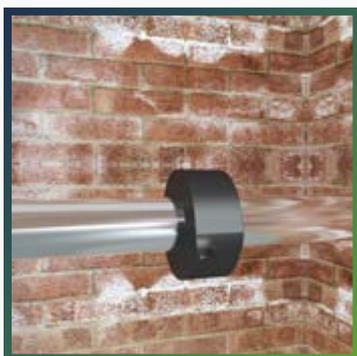
Закройте механизм подвеса, зафиксировав место стыка самоклеящимся клапаном.
