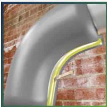
Смонтируйте полученное изоляционное колено на трубопровод, нанесите слой клея THERMAFLEX на торцевые поверхности меньшего радиуса, дайте клею время немного просохнуть, прижмите склеиваемые поверхности.
