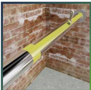
Нанесите тонкий слой клея на трубопровод в местах, планируемых для склейки. В течение 2-12 минут, в зависимости от температуры окружающей среды, дайте клею возможность просохнуть до частичной полимеризации (клей не должен прилипать к пальцам).
