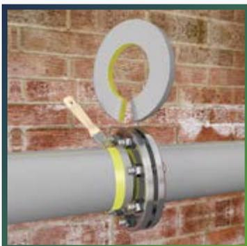
Вырежьте из листа теплоизоляции два кольца. Внутренние диаметры колец должны быть равны внешнему диаметру трубопровода (-2 мм), а внешний диаметр кольца должен соответствовать размерам фланца (+2 мм). Сделайте разрез для монтажа колец на трубопровод.
