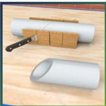
Возьмите теплоизоляцию подходящего размера, разрежьте ее на три отрезка таким образом, чтобы один из концов каждого отрезка был  $45^\circ$ , а другой –  $90^\circ$ .
