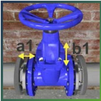
Вырежьте два изоляционных кольца и смонтируйте их у внешних сторон каждого из фланцев, соединив разрезанные концы с использованием клея THERMAFLEX (более подробное описание см. в п. 8.14). Измерьте расстояние между наружными поверхностями колец, установленных на фланцах. Определите длину окружности фланцев с помощью полоски изоляции соответствующей толщины.
