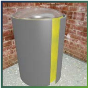
Перенесите полученные при измерении размеры на лист теплоизоляции, вырежьте по разметке деталь, нанесите клеевой слой на всю поверхность листа. После того, как клей подсохнет, смонтируйте деталь на емкость. Прижимайте материал к монтажной поверхности, прикатывая его монтажным роликом для удаления пузырьков воздуха и для обеспечения максимальной адгезии.
