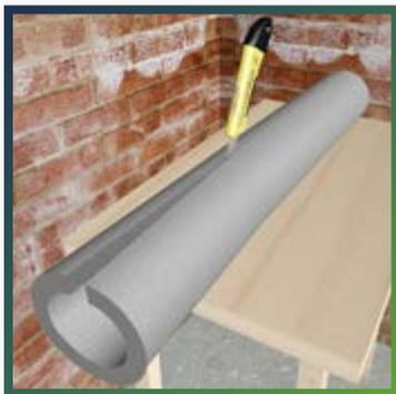
Аккуратно разрежьте трубную изоляцию по технологическому шву вдоль от начала до конца трубки. При резке нож следует держать перпендикулярно поверхности. Движения должны быть плавными и уверенными, без рывков, что обеспечит ровный разрез, без разрывов.
