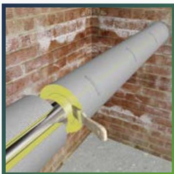
Для продолжения монтажа нанесите клеевой слой на торцевые поверхности теплоизоляции.
