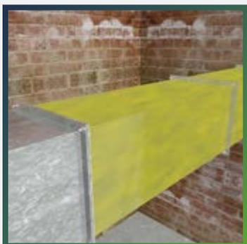
Используя кисть, валик, либо пистолет-распылитель нанесите клей THERMAFLEX на поверхность воздуховода. В течение 2-12 минут в зависимости от температуры среды дайте клею подсохнуть до частичной полимеризации (клей не должен прилипать к пальцам).
