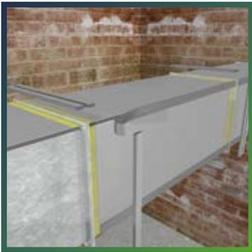
Для изоляции фланцев воздуховода вырежьте из изоляционного листа планки подходящего размера. Нанесите клеевой слой на места прилегания изоляции к фланцам и на приклеиваемую поверхность планок.
