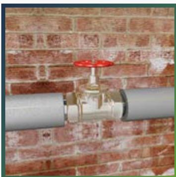
Произведите изоляцию труб вплоть до крана (см. п. 8.3). Измерьте габариты крана и подберите теплоизоляцию для крана, ее внутренний диаметр должен быть равен внешнему диаметру смонтированной на прямые участки трубопровода изоляции.
