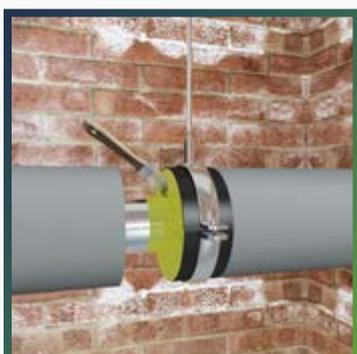
Нанесите тонкий слой клея THERMAFLEX на торцы подвеса и выполните монтаж теплоизоляции на прямых участках трубопровода.
