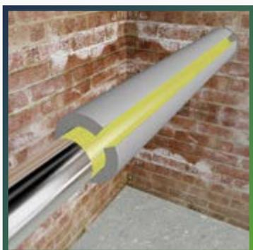
Оберните трубопровод листом теплоизоляции, нанесите клей на внутреннюю поверхность теплоизоляции (на глубину 20 мм) в местах присоединения к трубопроводу и соедините обработанные клеем поверхности, начиная от края листа к его середине, чтобы избежать перекосов. Прижмите.
