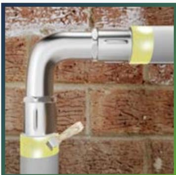
Также нанесите клеевой слой на прилегающие участки уже смонтированной изоляции. Установите угловой изолирующий элемент на отвод трубопровода. Тщательно склейте все поверхности разреза и места стыковки с изоляционной подложкой, используя клей THERMAFLEX, прижмите склеиваемые фрагменты изоляции.
