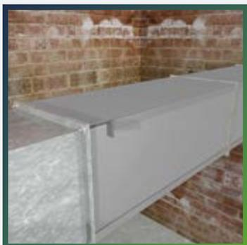
Зафиксируйте стыки самоклеящейся лентой Thermatape.
