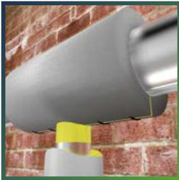
На участок трубопровода, прилегающий к месту соединения труб различного диаметра, а также на торец трубки, смонтированной на отвод Т-образного соединения, нанесите тонкий слой клея. Дайте клею время слегка подсохнуть, после чего соедините склеиваемые поверхности, прижав их друг к другу.
