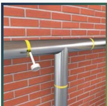
Чтобы избежать смещения изоляции нанесите в местах ее монтажа клеевой слой на трубопровод.
