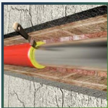
Нанесите тонкий ровный слой клея THERMAFLEX на торец теплоизоляционной трубки, дайте клею немного времени, чтобы просохнуть.
