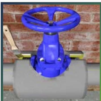
Нанесите клей на соединяемые торцы вырезанной изоляционной детали.
