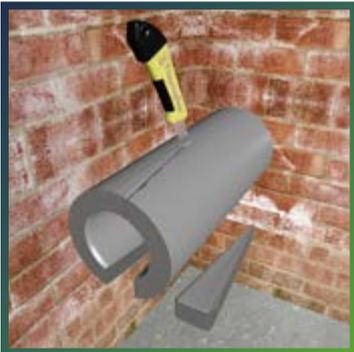
С одного конца отрезанного фрагмента теплоизоляционной трубки вырежьте 2 V-образных сегмента, как показано на рисунке.
