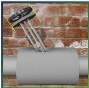
Измерьте диаметр колеса крана вентиля и диаметр механизма вентиля. В соответствии с полученными размерами вырежьте из теплоизоляционного листа кольцо с разрезом на одной стороне. Смонтируйте кольцо, как показано на рисунке.
