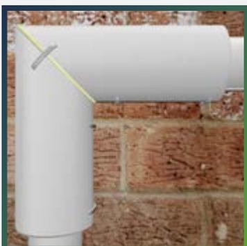
При необходимости зафиксируйте швы монтажными клипсами THERMACLIPS.
