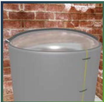
Также применяя узкую полоску теплоизоляции, измерьте поверхность крышки изолируемой емкости.
