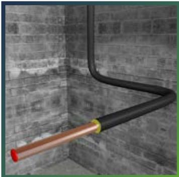
За счет эластичности изоляция хорошо удерживается на поверхности трубопровода, в том числе на изгибах большого радиуса. Однако, чтобы избежать смещения, край теплоизоляционной трубки следует зафиксировать (приклеить) к трубопроводу клеем THERMAFLEX.
