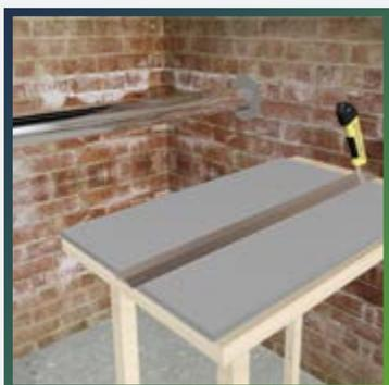
Отметьте полученный размер на листе теплоизоляции, аккуратно отрежьте
