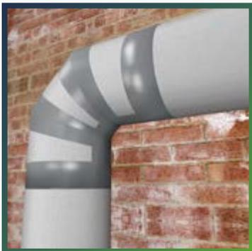
Через 24 часа, после полного высыхания клея, снимите клипсы и проклейте швы армированным скотчем POLYKEN для герметизации соединений.
