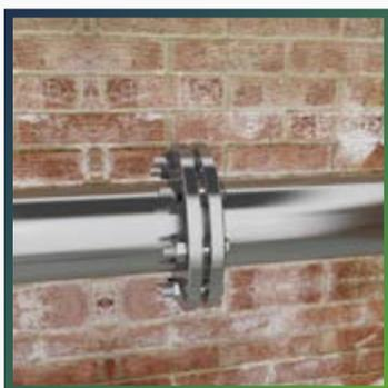
Для изоляции фланца требуется точно измерить фланец и аккуратно вырезать изолирующие детали из листовой теплоизоляции.
