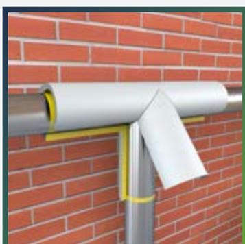
Через 2-12 минут, в зависимости от температуры окружающей среды, когда клей подсохнет (перестанет прилипать к пальцам), аккуратно смонтируйте полученную деталь на трубопровод.
