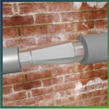
При наличии на трубопроводах участков переменного сечения (редукции), монтаж теплоизоляции следует начинать с прямых участков.
