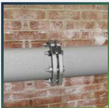
Выполните изоляцию трубопровода на прямых участках вплоть до фланца (инструкцию см. в п. 8.3 или п. 8.12 в зависимости от диаметра изолируемого трубопровода, - менее или более 159 мм).
