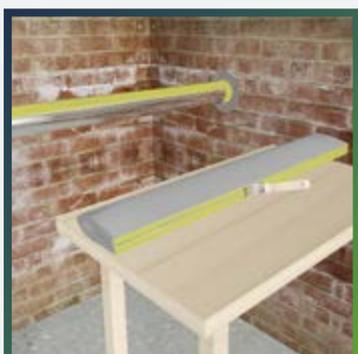
Отрезанный кусок листовой теплоизоляции сложите пополам и нанесите клей одновременно на обе торцевые склеиваемые поверхности листа.
