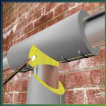
Нанесите клеевой слой на трубопровод в месте соединения двух труб, затем смонтируйте короткий отрез на отвод Т-образного соединения.
