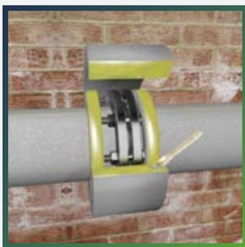
Оберните фланец прямоугольником из теплоизоляции и склейте.
